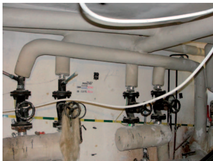
Węzeł cieplny przed remontem w budynku nr 10 przy ulicy Porazińskiej.
