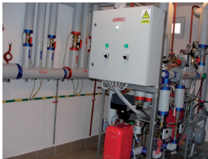
Nowy, wysokoparametrowy węzeł cieplny G-Power firmy GEBWELL sp. z o.o. do systemu ogrzewania i przygotowania ciepłej wody użytkowej dla budynku nr 10 przy ulicy Porazińskiej.
